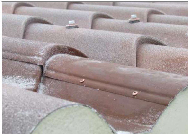
Ejemplo de uso correcto de los remaches
